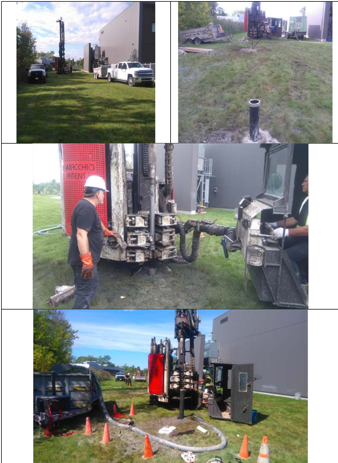
Figure A2 : Opérations de forage.
