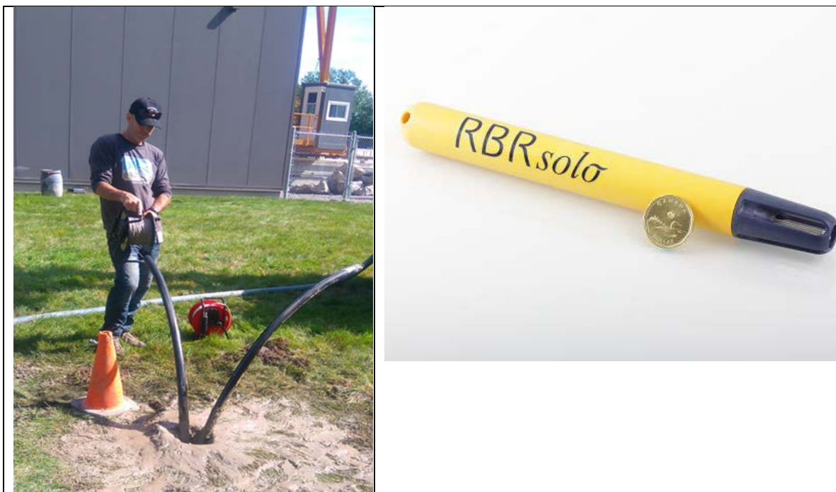
Figure A6 : Mesure de la température dans la boucle géothermique et sonde de pression et de température RBR.
