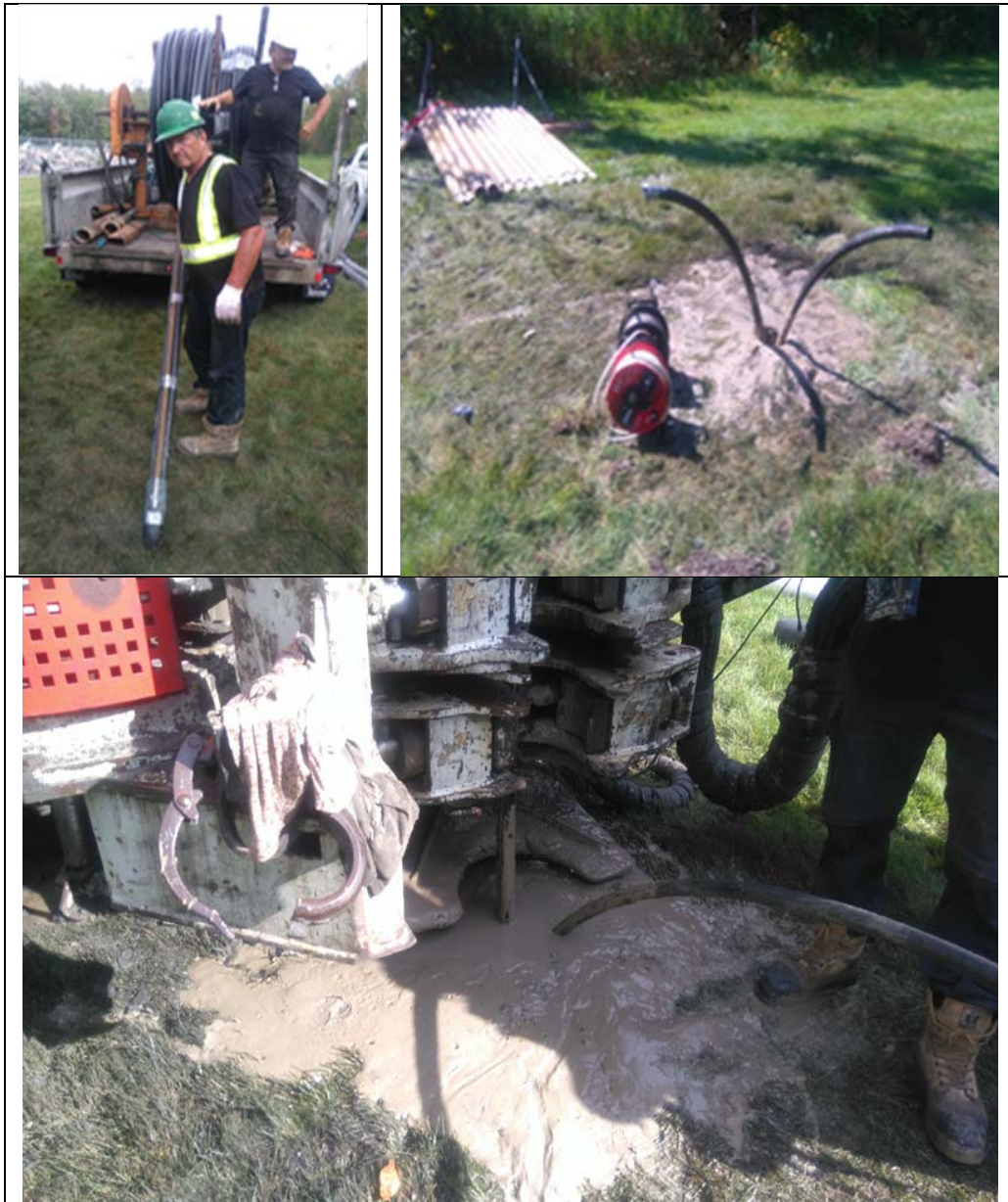
Figure A3 : Mise en place de la boucle géothermique en HDPE et du coulis dans le forage.
