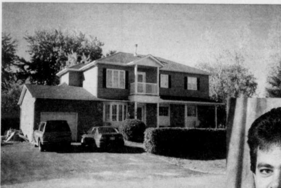
En transformant sa demeure en maison bigénération, le conseiller Pierre Isabel, en mortaise, aurait aimé qu'Otterburn Park s'en serve comme projet pilote.
