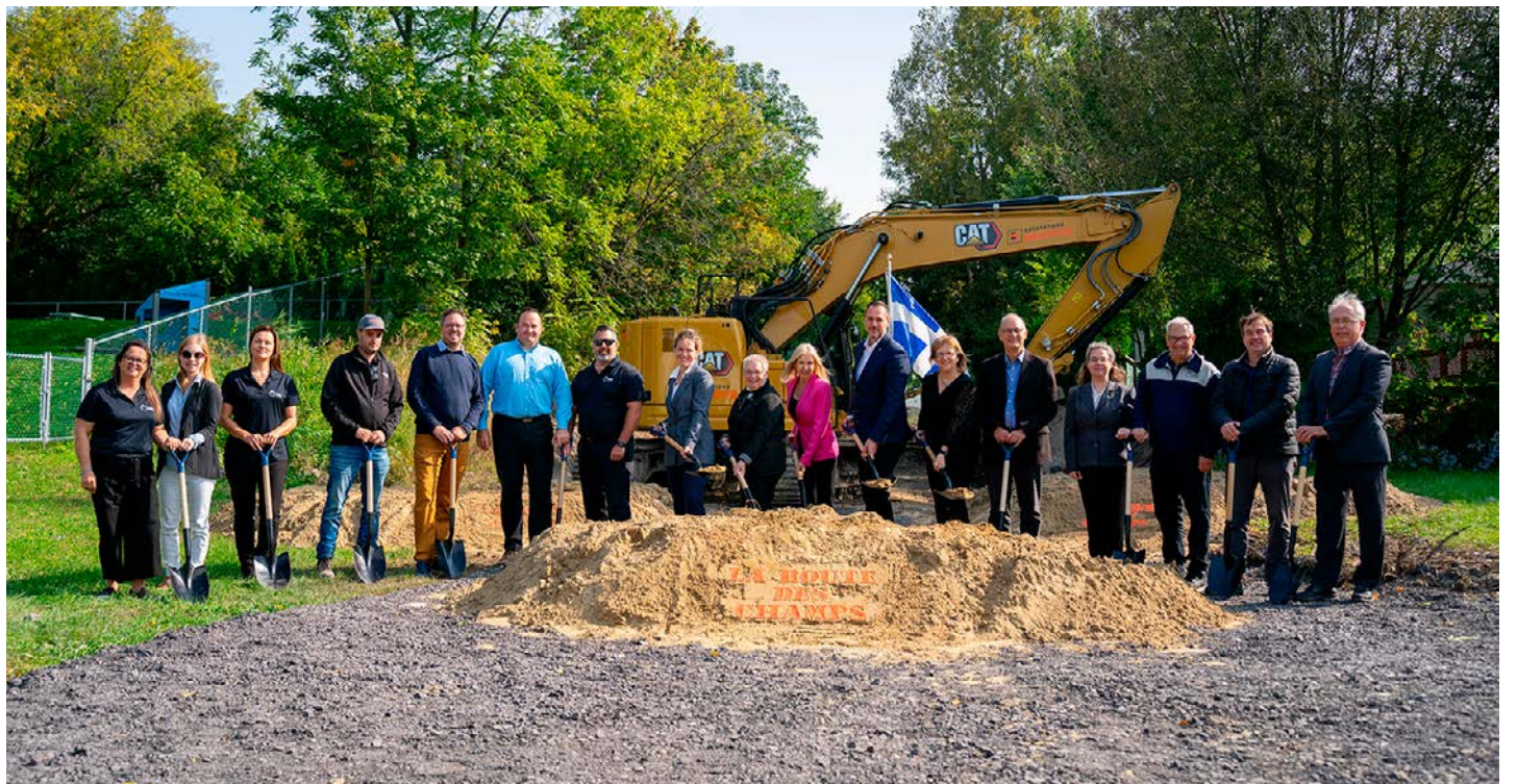
Élus et maîtres d'œuvre étaient présents lundi dernier pour inaugurer les travaux! (Photo : MRC Rouville)
