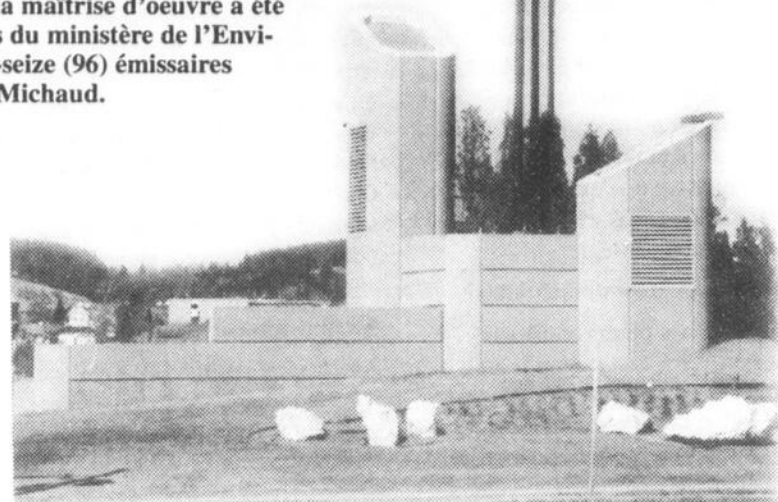
Sur la zone portuaire: le coeur du nouveau système de pompage des eaux usées.
