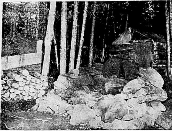
CAMP GAGETOWN — Voici un abri temporaire érigé par les soldats du 22 e bataillon, Royal 22 e Régiment, construit de bois rond. A l'avant-plan, on voit un foyer qui sert au séchage du linge, à l'éclairage et au chauffage.
