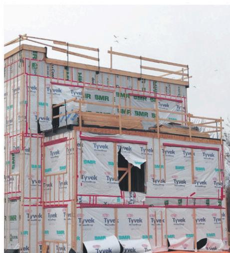
Les Condos du lac commencent à prendre forme avec la construction d'un premier bâtiment de cinq unités d'habitation.
