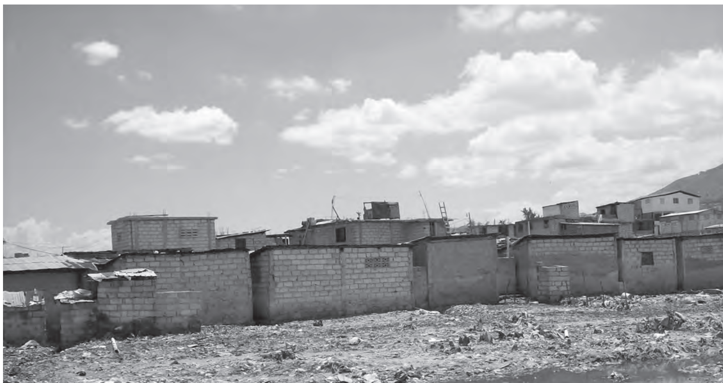
CITÉ PLUS (PORT-AU-PRINCE HAÏTI) DES LOGEMENTS CONSTRUITS PRÈS DU CANAL BOIS-DE-CHÊNE. CHAQUE FOIS QU'IL PLEUT CE CANAL DÉBORDE ET, LES GENS SONT OBLIGÉS D'ABANDONNER LEUR DEMEURE. PHOTO : ILIONOR LOUIS, AVRIL 2007
