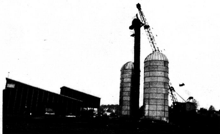
Construction de silos à grain chez les Engrais Chimiques Harbec Inc.
