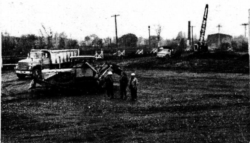
Photo Harbec Le maire et 2 ouvriers sur le chantier
