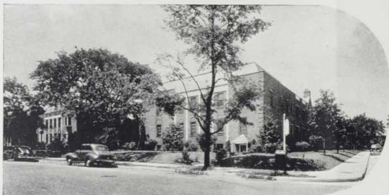
Une Maison Appartement comprenant un Système Monoflo de Neufs Circuits. Des Circulateurs contrôlent la Température de Chaque Circuit.
