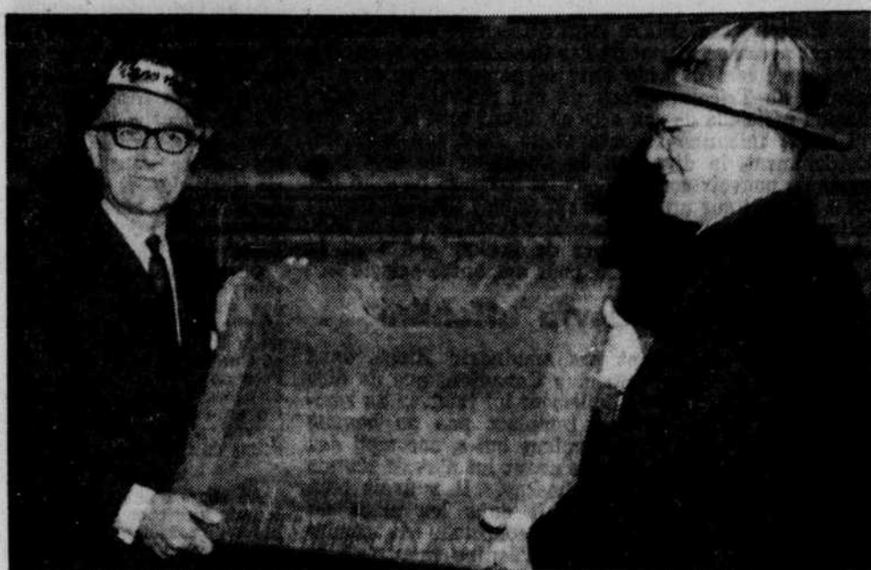
Samedi dernier le premier coup de bélier était porté à l'ancien immeuble de la Banque Canadienne Nationale, Place d'Armes. Bientôt s'élèvera à cet emplacement un édifice moderne de 32 étages, qui logera le siège social de la banque. Sur la photo, de gauche à droite, M. Louis Hébert, président de la Banque Canadienne Nationale, remettant à M. Albert Lapointe, p.s., qui remplaçait le curé de la paroisse Notre-Dame, la plaque commémorative qui se trouvait à l'angle des rues St-François-Xavier et Notre-Dame et qui sera remplacée au même endroit sur le nouvel immeuble.
