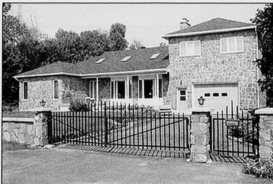
La clôture est l'un des premiers éléments que voit le visiteur ; il convient donc de la choisir avec grand soin.
