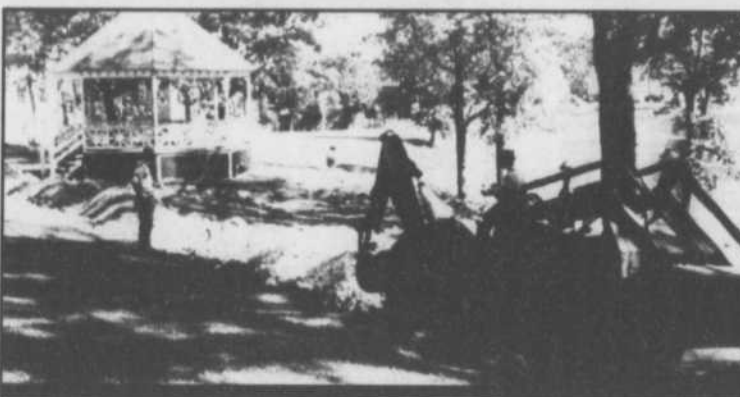
Le conseiller Antonio Daunais, promoteur du réaménagement du parc dans les années 1960, surveillant les travaux. (Photo : collection Aimé Despatis, Centre régional d'archives de Lanaudière)
