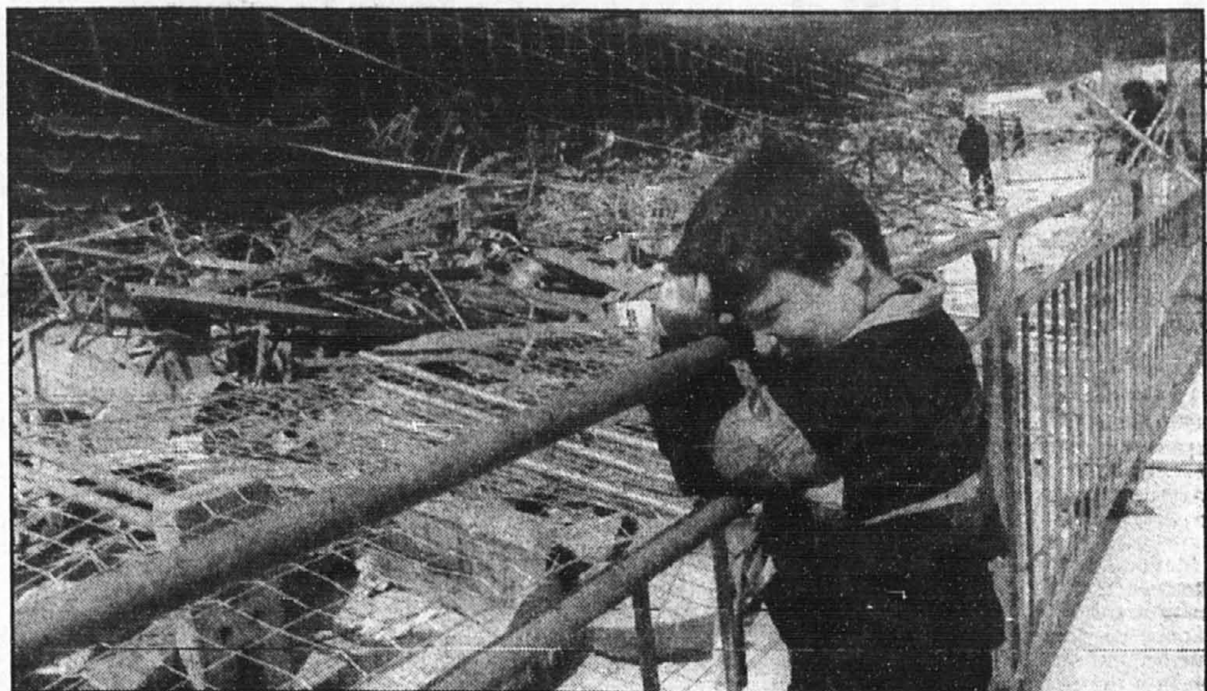
Un enfant s'appuie sur une grille de protection installée autour de la portion du stade de Bastia, en Corse, qui s'est effondrée avant un match de soccer, faisant 10 morts. PHOTO AFP
