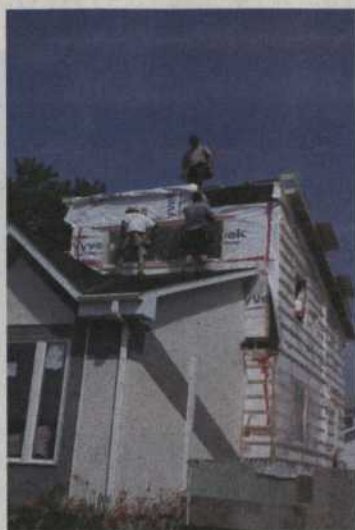
La famille Gardner s'est installée en septembre dernier après trois mois de rénovation.
