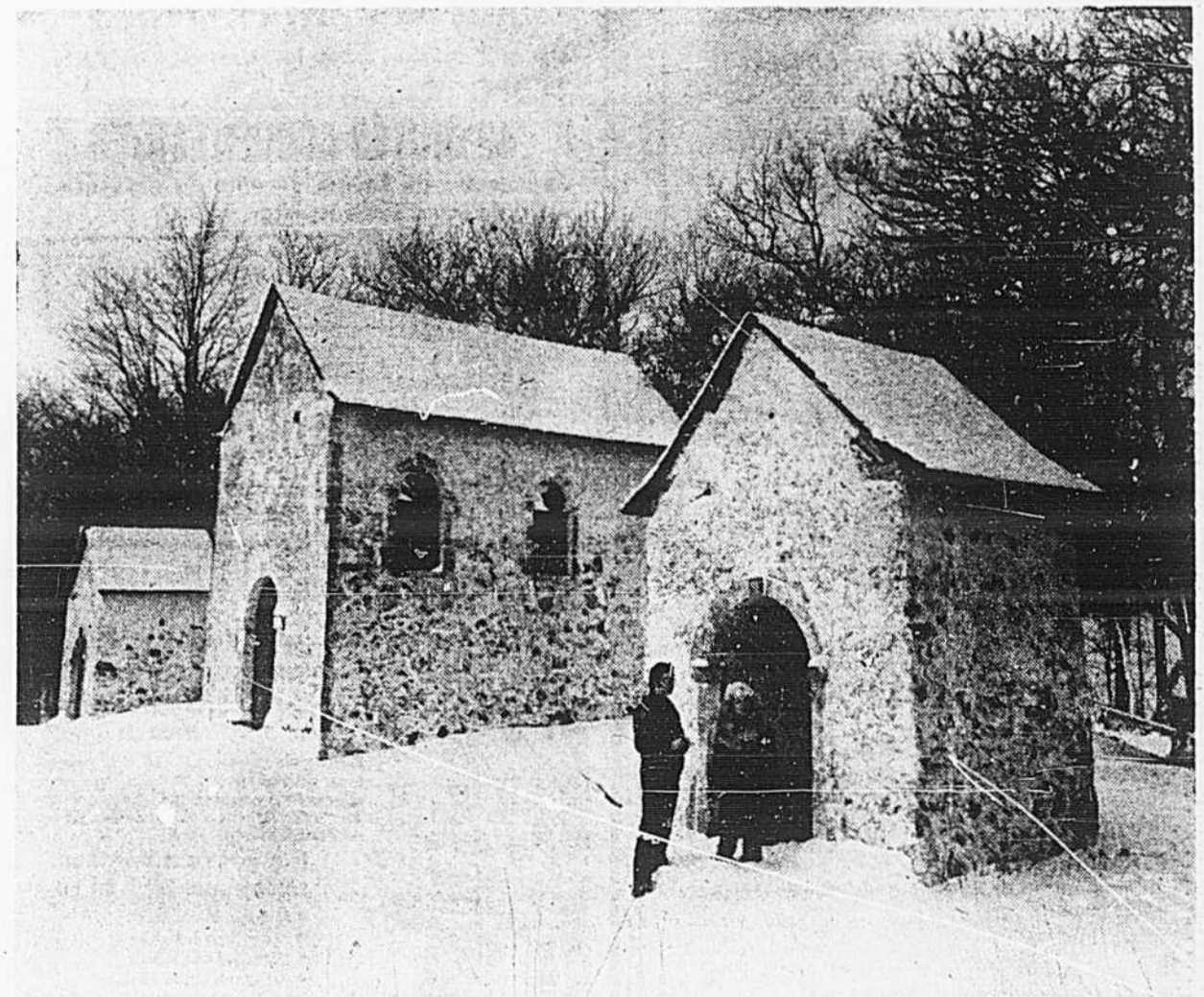
Les trois chapelles, au sommet du Mont Calvaire, dominent une vue merveilleuse sur le lac des Deux-Montagnes qu'admirent Mme Laurette Richer et M. Jean Renaud, adjoint au surintendant du parc Sauvé. Ces chapelles ont perdu ces dernières années les croix qui les surmontaient, de même que les trois immenses croix qui leur faisaient face.
