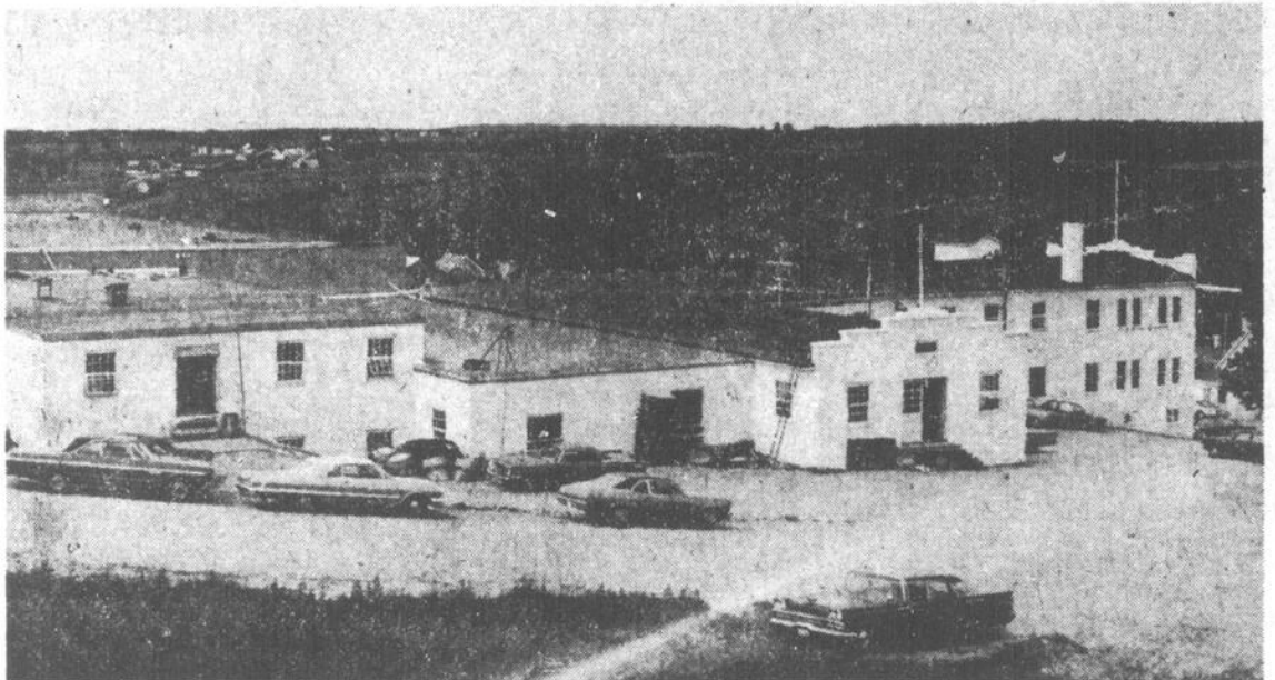
Le plan actuel de la firme "Les Industries Provinciales Ltée" de Saint-Damien de Bellechasse.
