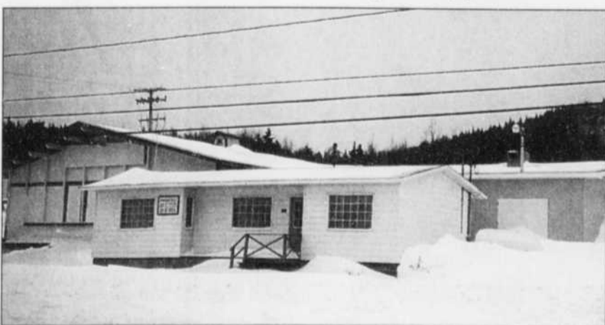
L'usine Tourelle Marée est au coeur d'une saga judiciaire.
