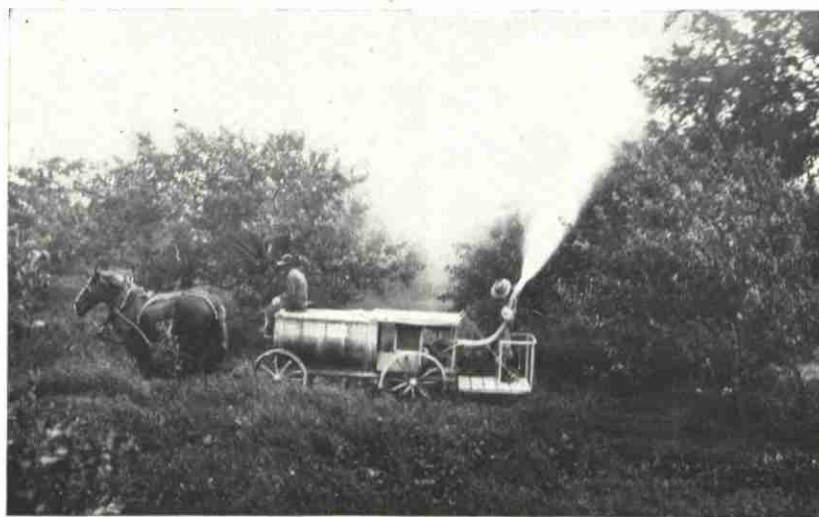
FIG. 1.—Pulvérisateur "Liquiduster" à grand débit, en opération dans un verger commercial. (Photo J. M. Talbot.)
