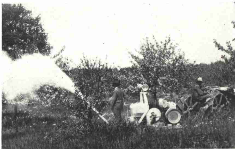
FIG. 2.—Saupoudreuse utilisée comme auxiliaire du pulvérisateur dans un grand verger. (Photo J. M. Talbot).
