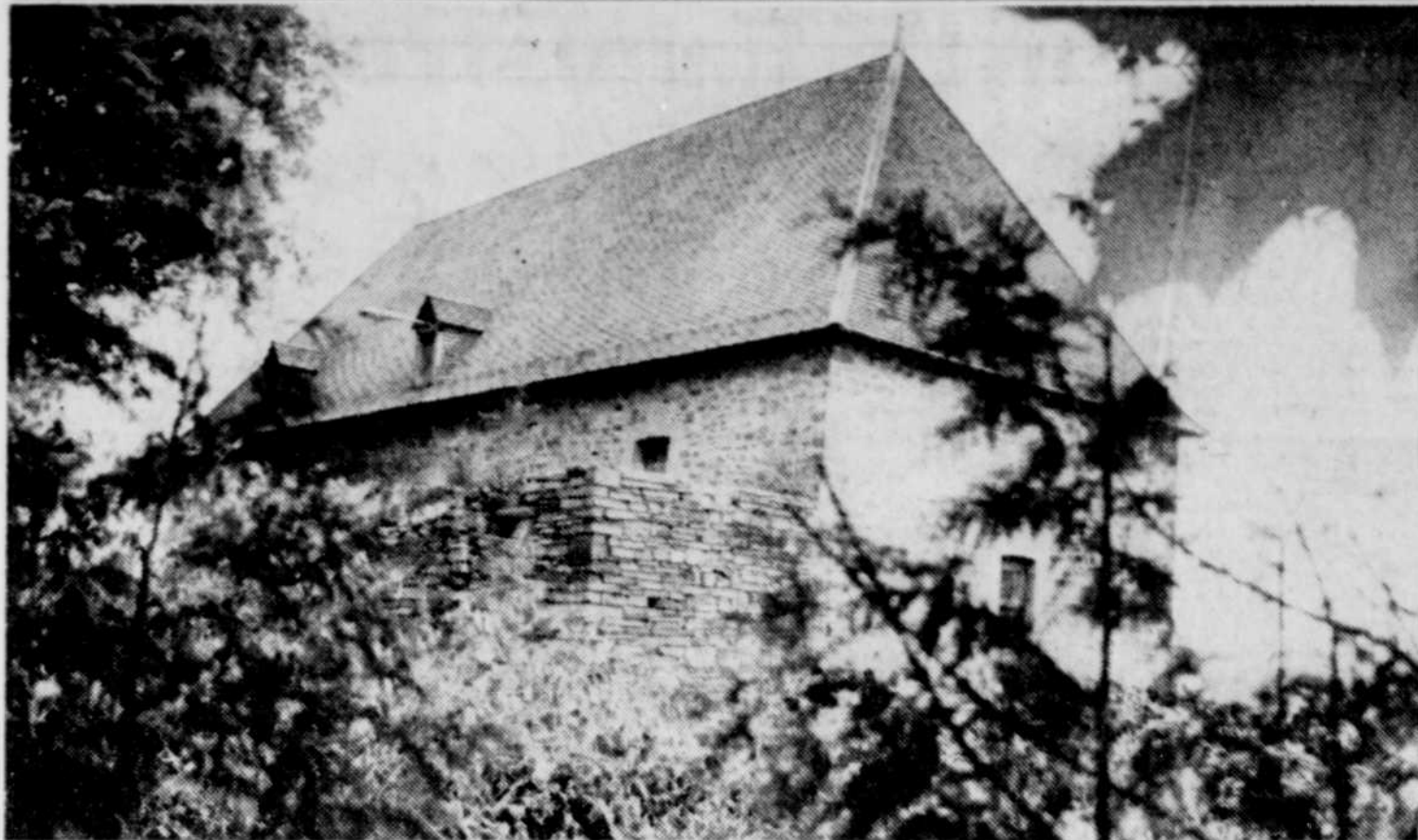
On veut redonner au moulin du Petit-pré sa vocation originelle.
