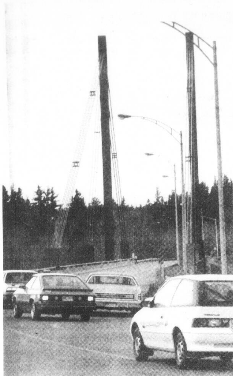
FERME — Le pont Kénogami est fermé à la circulation automobile le temps d'effectuer des travaux de rénovation à la structure. (Photo Rocket Lavoie)
