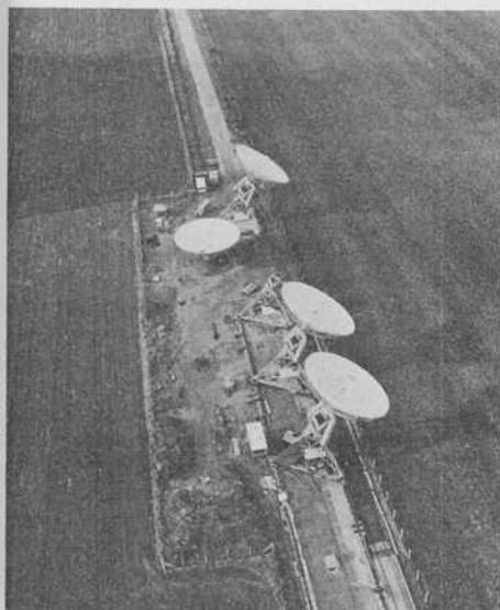
▲ SYNTHÈSE D'OUVERTURE — Le nouveau radiotélescope de l'Observatoire Mullard, à Cambridge (Angleterre), est de conception révolutionnaire. Par une combinaison de plusieurs petites antennes déplacées sur plusieurs kilomètres, ce radiotélescope équivaut à une seule antenne qui aurait quelque 5 kilomètres de diamètre. C'est le professeur Martin Ryle, de l'Université de Cambridge, qui a mis au point cette technique dite de synthèse d'ouverture. C'est précisément ce qui lui a valu d'être nommé co-lauréat du prix Nobel de Physique 1974. En combinant plusieurs petites ouvertures il est possible d'en « synthétiser » une grande.
