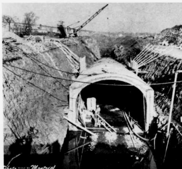
Le tunnel, servant de passage au Métro, est mis en place et puis la tranchée se referme
