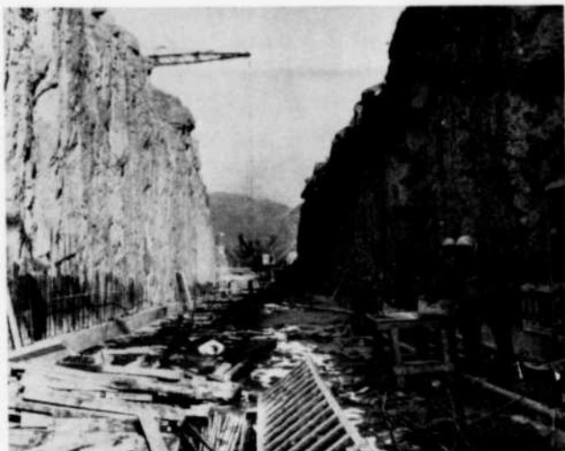
Une image imposante des travaux du Métro à travers l'île Ste-Hélène
