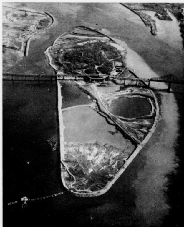
Opération de dragage. Ile Ronde partiellement remblayée. L'opération s'est poursuivie sur l'île Verte. Sols fins en suspension visibles dans l'eau du fleuve.
