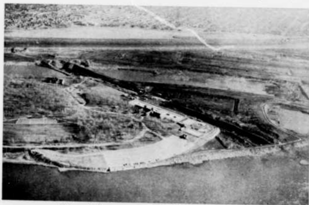
Tranchée ouverte sur l'île Ste-Hélène
