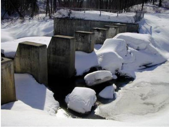
Figure 44 : Vue de l'amont de l'estacade de la rivière Duberger à la fin de l'hiver 2000-2001. Résidus de glace accumulés en amont de l'estacade (Delcourt, 20 mars 2001)
