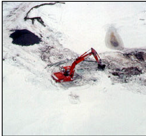
Figure 13 : Pelle mécanique en difficulté lors des travaux effectués suite aux événements de mars 92 (Ministère de l'Environnement du Québec)
