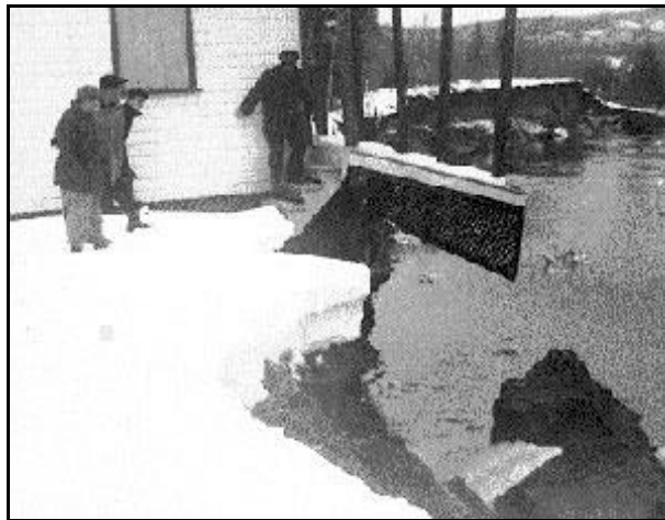
Figure 20 : Érosion des berges suite à la purge rapide de l'eau retenue derrière l'embâcle de décembre 1957
