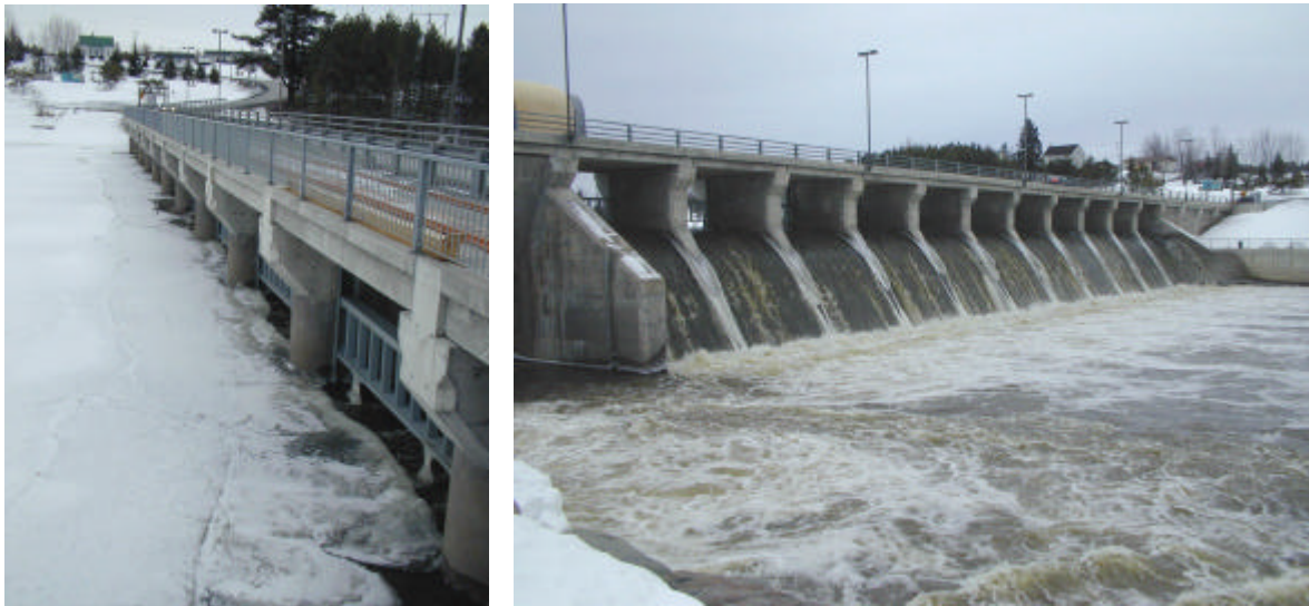
Figure 55 : Face amont du barrage Sartigan (Delcourt, hiver 99-00)
