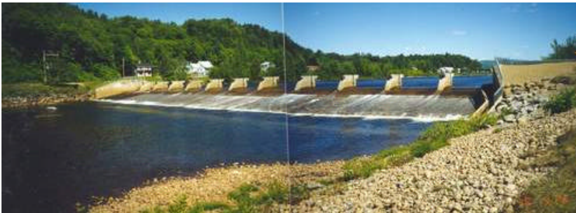
Figure 38 : Estacade de Saint-Raymond de Portneuf (Source : Ministère de l'Environnement)
