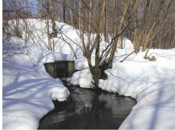
Figure 44 : Vue de l'amont de l'estacade de la rivière Duberger à la fin de l'hiver 2000-2001. Résidus de glace accumulés en amont de l'estacade (Delcourt, 20 mars 2001)
