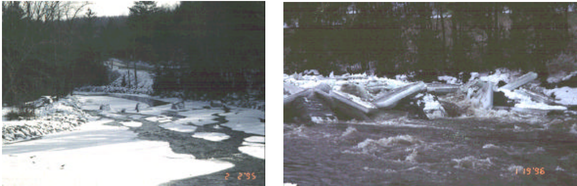
Figure 50 : Vue de l'estacade de Hardwick durant les hivers 1995 et 1996 (URL du CRREL, 2000)
