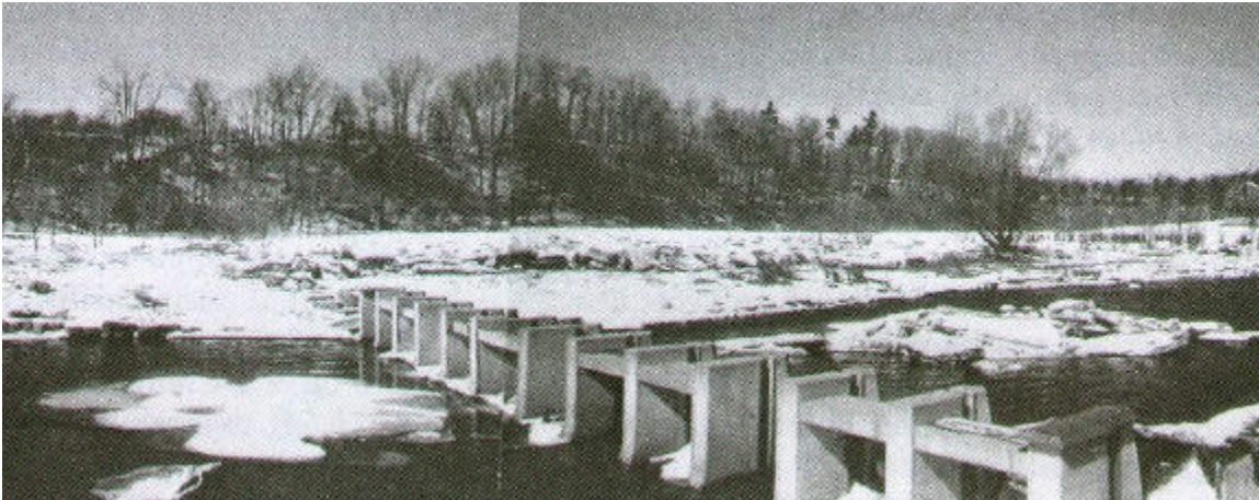
Figure 52 : Estacade de la rivière Credit (Mississauga, Ontario). Vue de la structure et de la plaine inondable (Tuthill, 1995)
