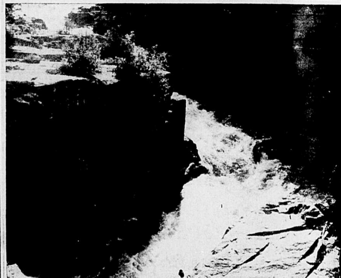
LE PONT DES DALLES — Depuis plusieurs années il était désiré par les paroissiens de relier les deux rives séparées par la rivière L'Assomption. Le 11 mars 1868, on adopta le devis du pont des Dalles. "La Gazette de Joliette" doit publier des demandes de soumission et, en même temps, la lecture du devis du pont doit être faite à la porte de l'église de Ste-Béatrix. Quelque temps après, le pont est construit et les paroissiens des deux rives, remplis de joie, se donnent fraternellement la main au centre du pont.
