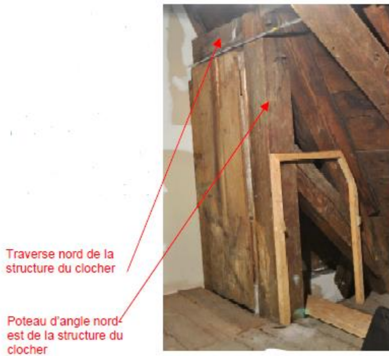
Photo 9 : Section nord-est de la structure du clocher.
