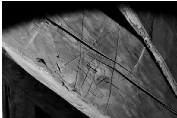
Photo 6 : Aisselier 17 (T-4) nord.
