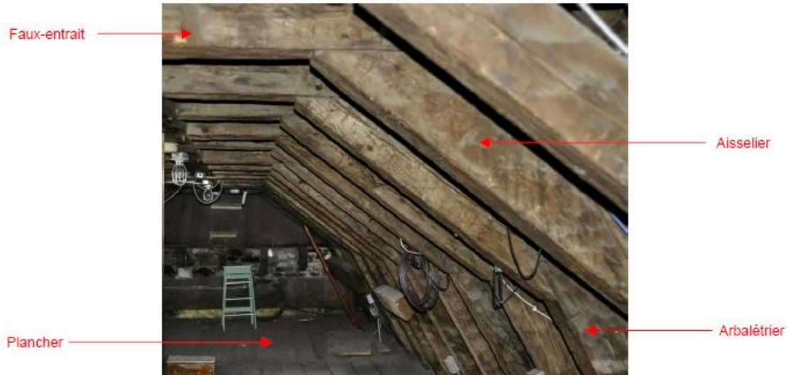
Photo 2 : Espace libre dans le comble de l'église de Notre-Dame-des-Anges.
