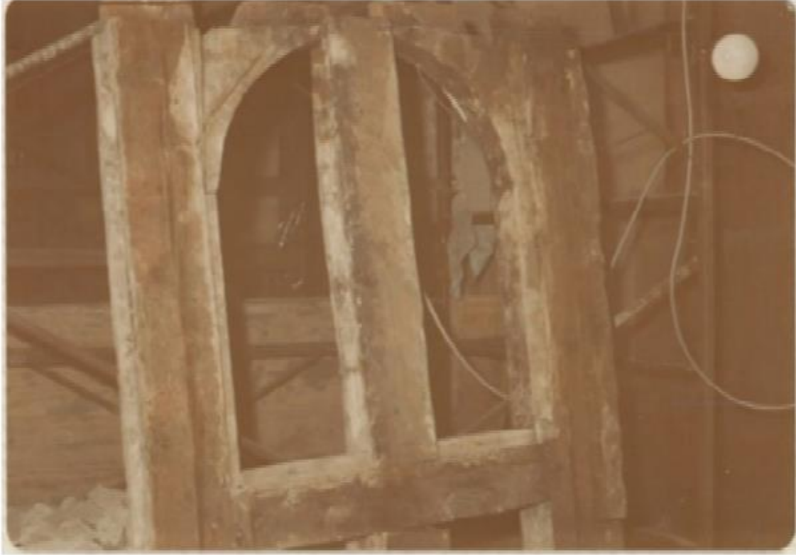
Photo 13 : Fenêtre du niveau B, 8 décembre 1982, Québec, Le Monastère des Augustines, HG-A-26 (Restauration de l'église, n° 443).
