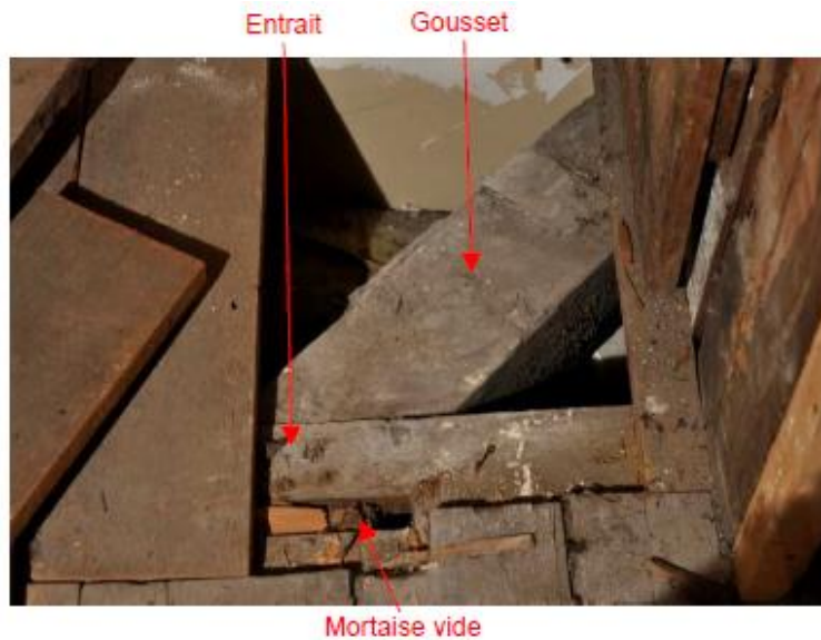
Photo 11 : Coin nord-est de la plateforme du clocher.
