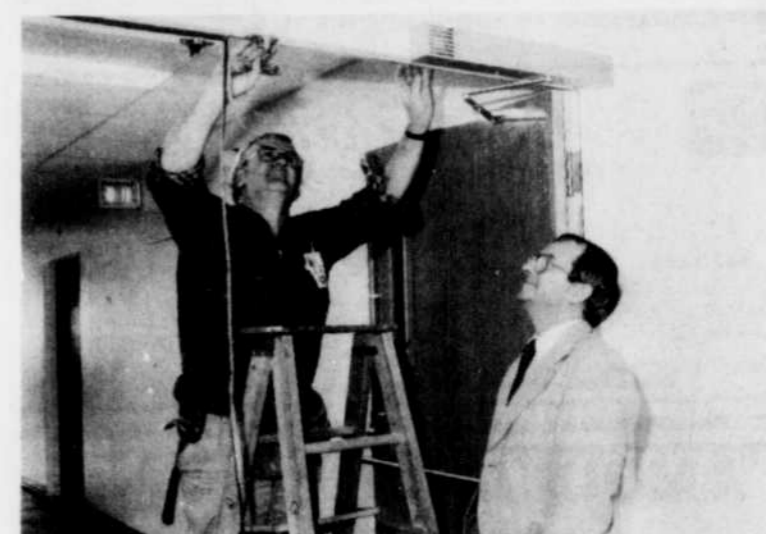
(Photomédia Claude Gill) L'installation d'une porte coupe-feu assurera une sécurité grandissante au huitième étage du Centre Hospitalier Régional de la Mauricie.
