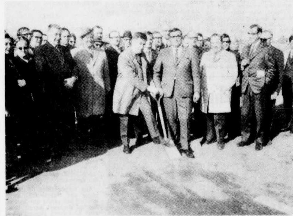
LA DIXIEME EN UN AN — Samedi après-midi avait lieu dans le parc industriel de Granby, la cérémonie de la première pelletée de terre en vue de la construction de l'usine de la Safeway Farm Equipment. Le maire Jean-Louis Tétrault a procédé à cette opération symbolique, en présence de nombreuses personnalités, dont M. Gilbert Rondeau, député fédéral, M. Pierre H. Boivin, commissaire industriel, M. Jules Chopin, président de la compagnie, accompagné d'autres dirigeants de la firme, les représentants des autorités provinciales, du ministère fédéral de l'Expansion économique régionale, et des délégués de différentes associations locales. Précisons que c'est la 10e industrie à s'installer dans le parc industriel de Granby, depuis que M. Tétrault accédait à la mairie, il y a exactement un an. (Photo La Tribune, Granby)
