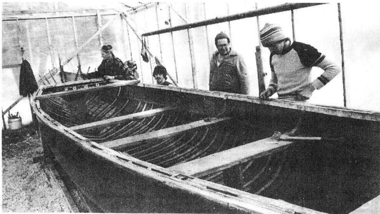
CONSTRUCTION — Quatre personnes travaillent présentement à la construction du drakkar. Il s'agit, dans l'ordre habituel, de Philippe Morissette, René Tremblay, Marcel Harvey et Marc Simard.
