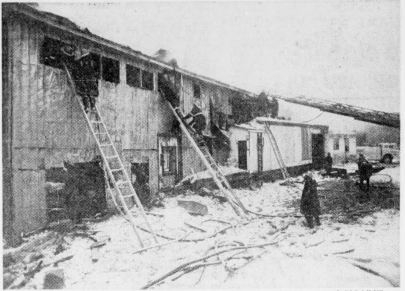
L'entrepôt Alphonse Allard, rue Saint-Pierre à Québec, a été détruit par les flammes.
