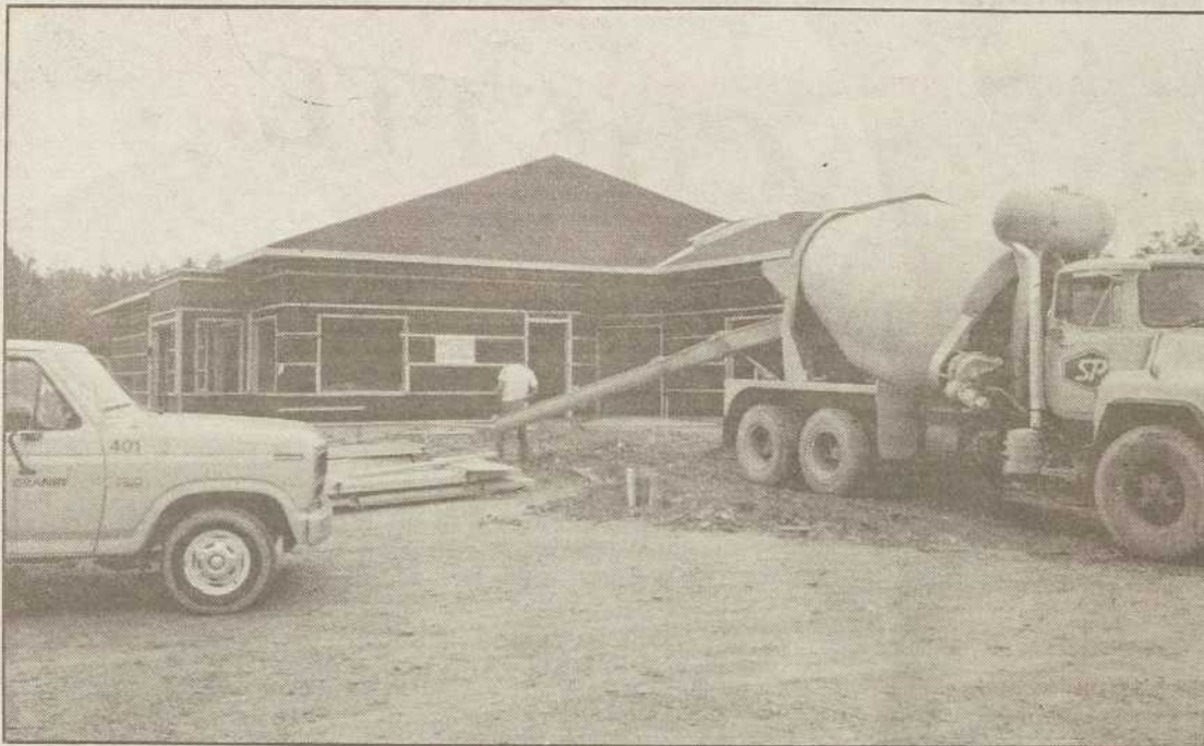
Les travaux avancent rapidement sur le chantier du futur "Panier à légumes du cantinier", au coin de St-Hubert et du boulevard David-Bouchard.
