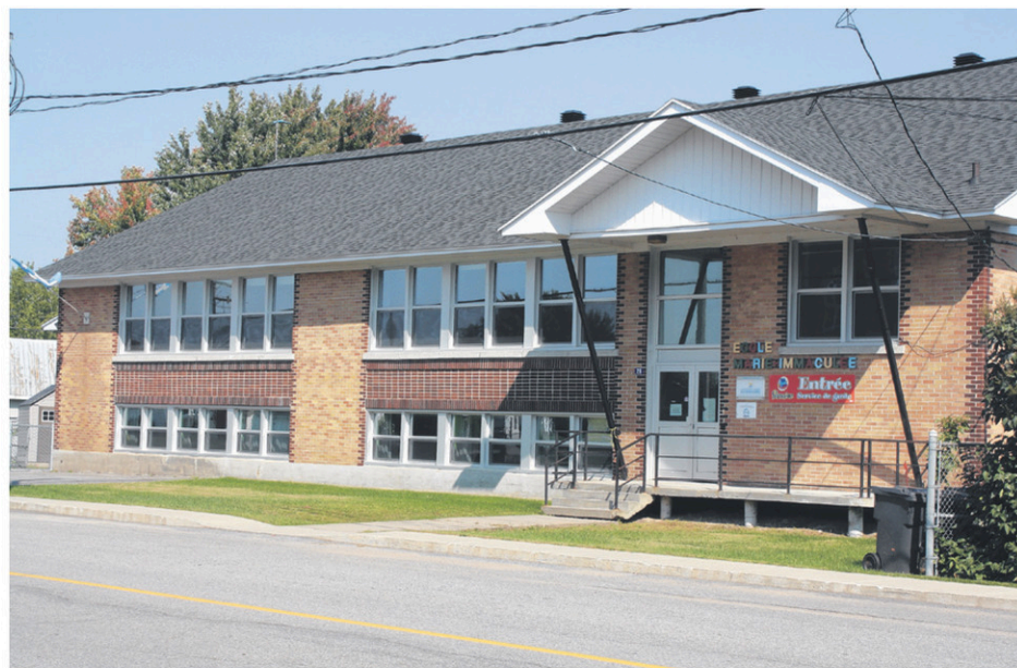
La Commission scolaire du Chemin-du-Roy poursuit son travail d'analyse sur l'école primaire Marie-Immaculée affectée par des problèmes au niveau de la structure et des fondations. (Photo TC Media - Pier-Olivier Gagnon)
