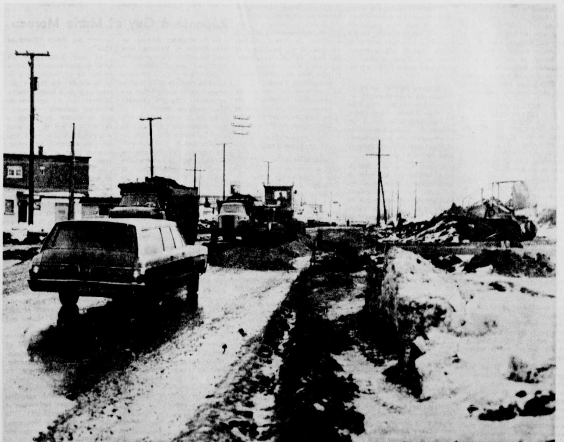
● Des hommes s'affairent présentement à la construction d'un viaduc sur la route 2 dans les limites de Duberger. Ces travaux ont pour effet de ralentir considérablement la circulation sur cette voie durant les heures de pointe. (Photo L'Action, par Marcel Laforee)
