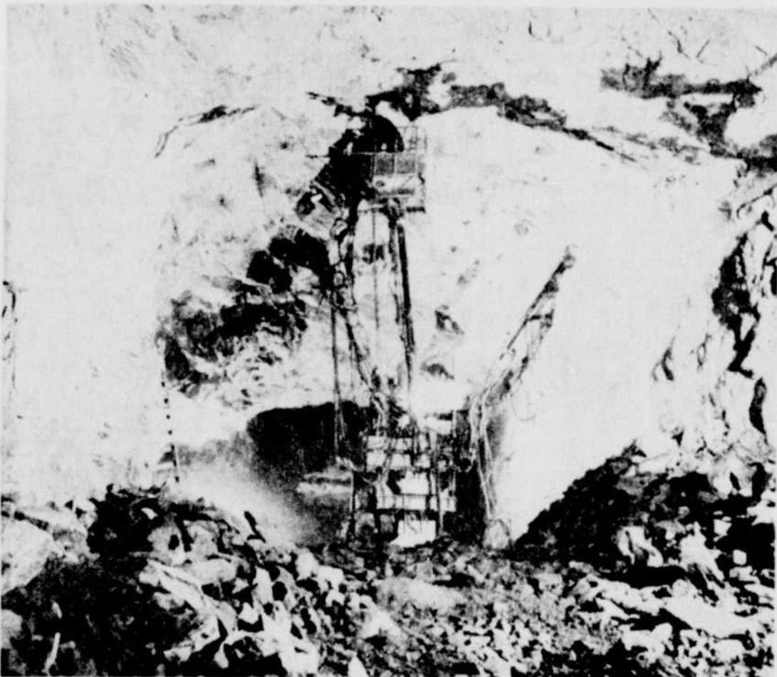
● LE DEPEÇAGE D'UNE MONTAGNE — A des centaines de pieds sous le plateau du Labrador, d'énormes machines creusent et taillent le roc dans lequel seront logées les salles et les galeries de la centrale hydro-électrique souterraine de Churchill Falls, la plus vaste installation du genre dans le monde entier. Le jumbo automoteur que l'on voit ci-dessus peut manoeuvrer dans presque toutes les positions pour s'attaquer aux parois rocheuses. Ici, il effectue le ravalement d'une section de voûte de la future centrale. Des fleches à commandes hydrauliques portent des perforatrices et une plate-forme permettant le chargement en explosifs des trous de mine. Une fois terminée, la caverne de la centrale mesurera 972 pieds de long, 81 pieds de large et aura une hauteur maximale de 154 pieds. Deux salles voisines, la chambre d'équilibre et la galerie des transformateurs, seront presque aussi grandes. Dans chaque cas, on commence par creuser, sur toute la longueur de la face supérieure, une galerie que l'on approfondit et élargit ensuite jusqu'aux dimensions définitives. A mesure que l'excavation s'étend, d'autres machines procèdent à l'installation d'un réseau de boulons d'ancrage qui assurent la stabilité de la charpente rocheuse.
