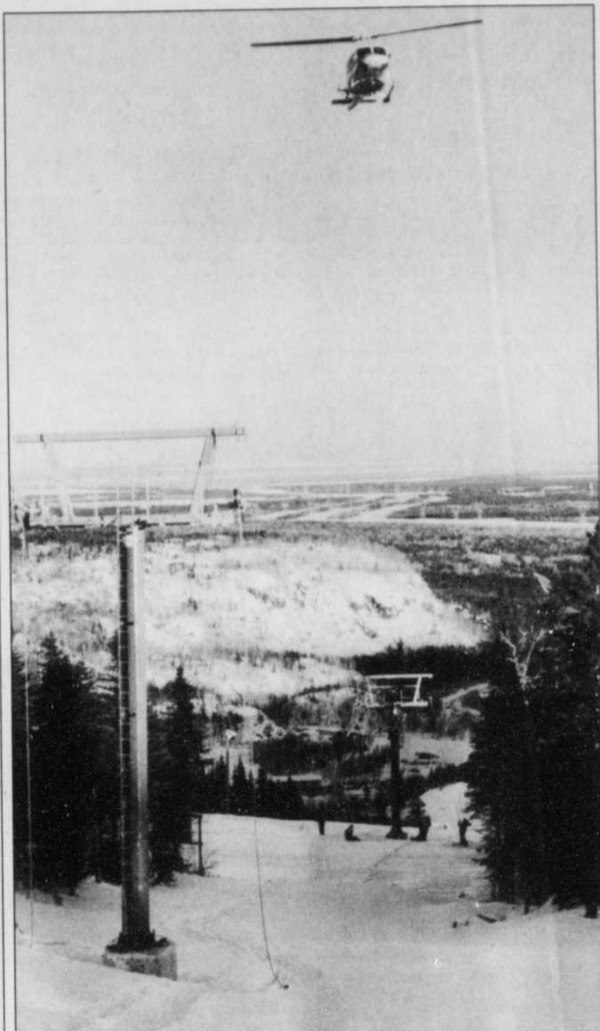
L'étape ultime de l'installation du télésiège était très spectaculaire. C'est avec l'aide d'un hélicoptère qu'on a procédé à la pose des principaux éléments.
