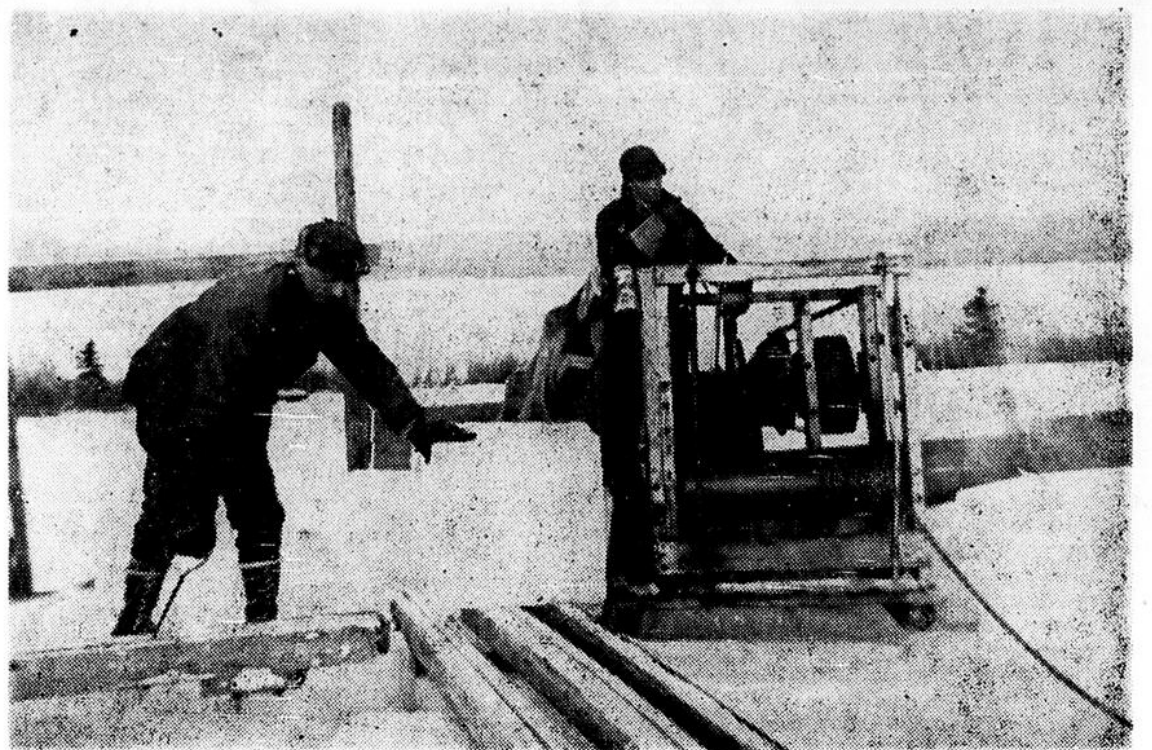
● Le chantier de la coupe de la glace sur le lac Matapédia, à Val-Brillant, a duré du 3 janvier au 24 février. Le contracteur, M. Yvon St-Pierre, de Sayabec, y a employé quotidiennement de 65 à 70 hommes et pour le charroiage, 18 chevaux. En moyenne, 20 chars de gros cubes de glace ont été coupés chaque jour. L'expédition de cette glace s'est faite vers Mont-Joli, Campbellton et Borden, I. P. E.
