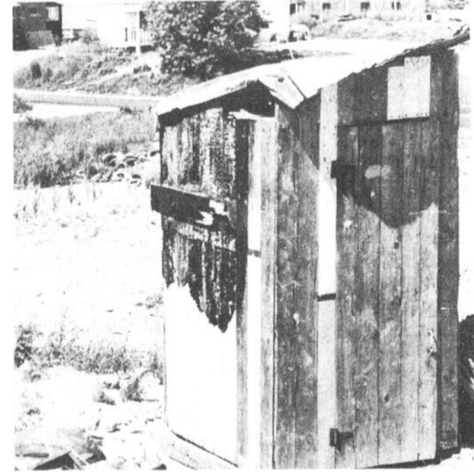
LES "CHIOTTES" SONT DE RIGUEUR — Pas d'eau, pas d'égoûts, pas de baignoires, pas de toilettes! Rien que des "bécesses" ou des "chiottes" pour certains résidents du secteur. D'autres plus fortunés ont des toilettes à l'intérieur, mais pas d'eau! Les fosses septiques éventrées s'égouttent vers le marais, contribuant à rendre infecte l'eau stagnante qui s'y est accumulée.
