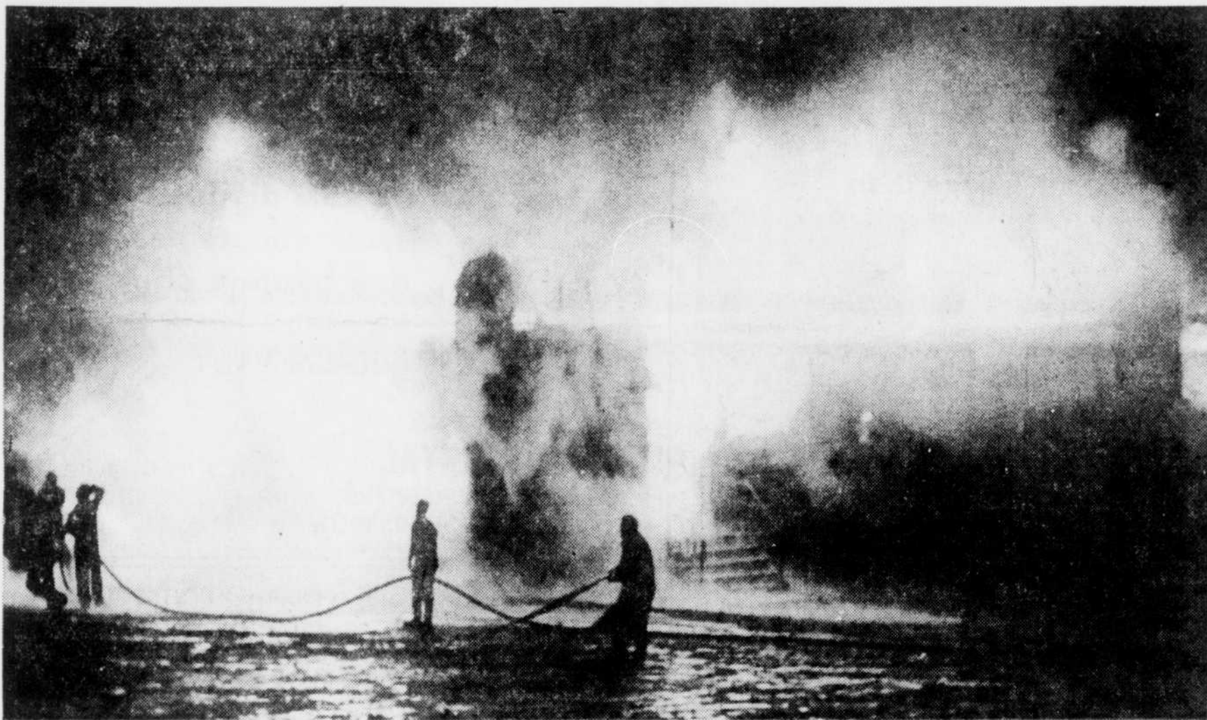
On pouvait apercevoir une lueur orangée dans le ciel à 20 milles du lieu de l'incendie qui a complètement rasé l'Auberge du lac Brompton. Les pertes seraient évaluées à $300,000. Même si 400 personnes se trouvaient à l'intérieur de l'établissement, personne n'a été blessée. (Photo La Tribune)
