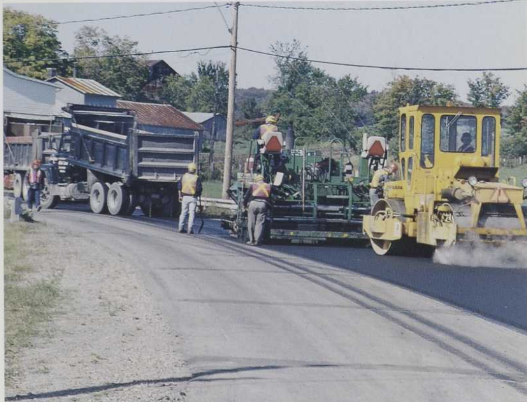
Lorsque la surface de la route est fissurée, on la recouvre d'environ 5 centimètres d'asphalte. Le bitume est étendu par une profileuse et roulé avec une compacteuse
