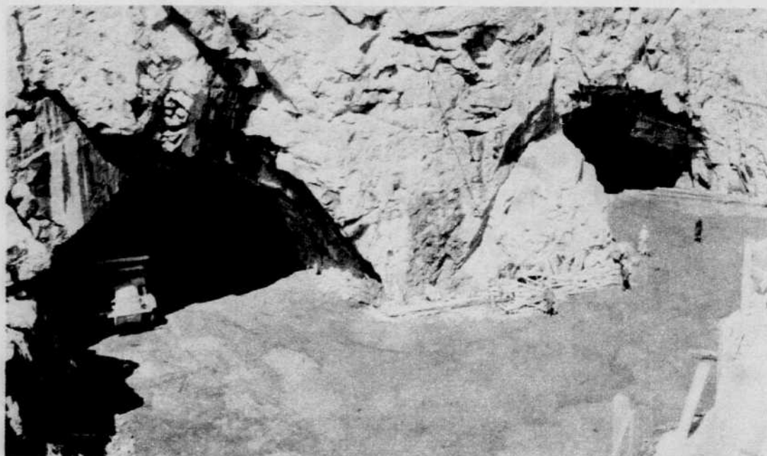
A gauche, les deux tunnels gigantesques qu'on a creusés dans le roc solide afin de détourner le cours de la rivière. Ci-dessus, les béliers et les pelles mécaniques rongent les couches glaciaires accumulées depuis des millénaires.
