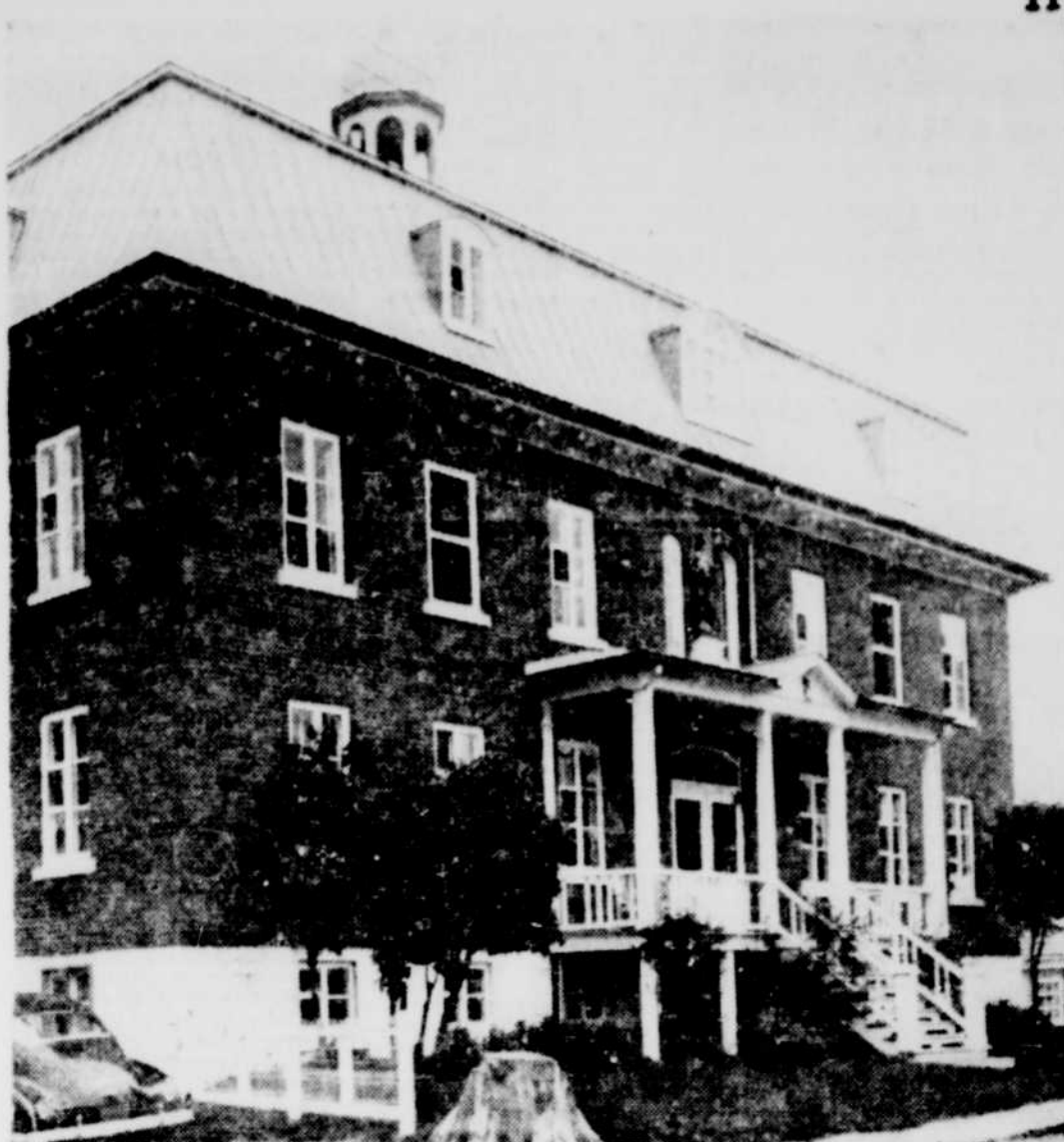
L'apparence extérieure de l'Académie Saint-Joseph, à Saint-Grégoire, a peu changé depuis la construction de l'école, il y a 76 ans. On a toutefois refait complètement le toit et la peinture.
