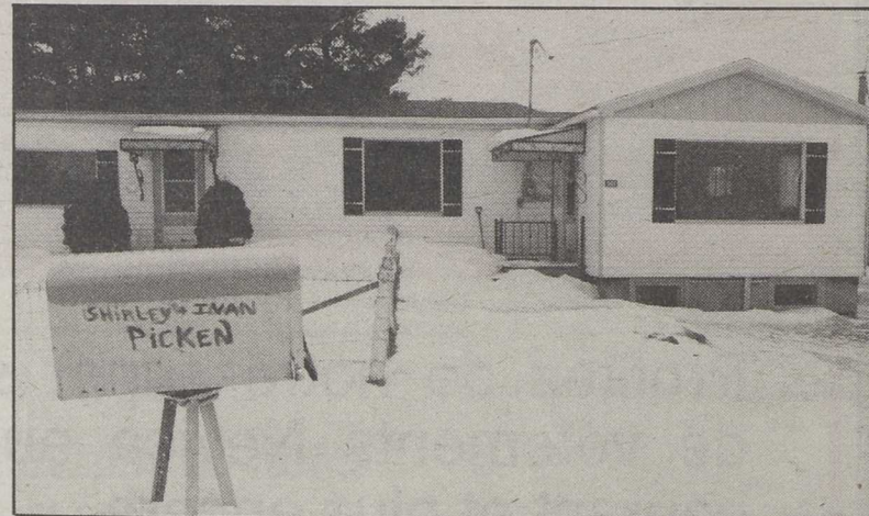
Cette maison inhabitée appartenant à David Picken, a été privée d'électricité durant cinq jours la semaine dernière en raison d'une erreur administrative du bureau régional de l'Hydro-Québec. La tuyauterie a complètement gelé sous des pointes de froid atteignant les -20 degrés Celsius.
