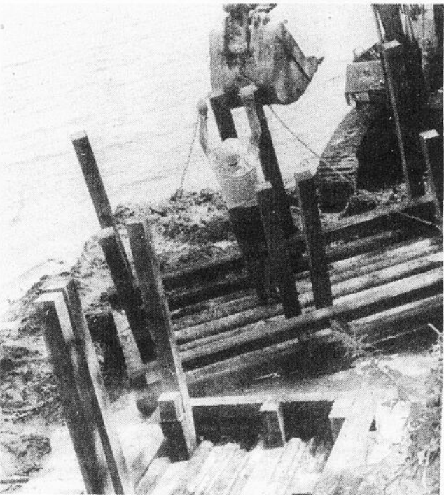
Les caissons, devant retenir la berge du lac Témiscouata, derrière les palissades du Fort Ingall, forment la courbe naturelle de la berge et seront retenus par un remplissage de pierres et recouverts de vignes.
