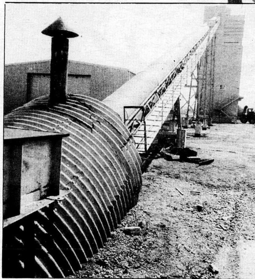
L'usine Almamix Ltée (Alma Mix Ltée) avec bétonnière au point de chargement de l'usine.
