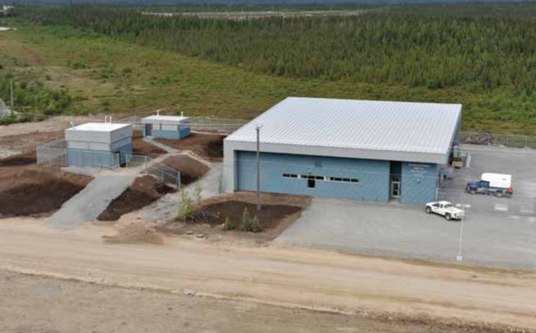
Nouvelle usine d'eau potable de Waskaganish
