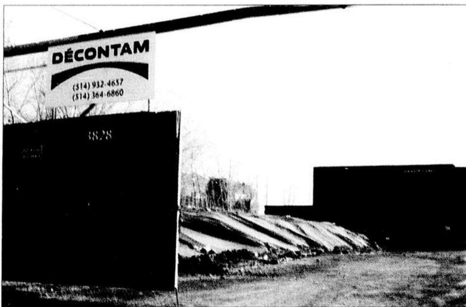
Le Groupe Cintec s'est donné comme objectif de concevoir et d'implanter les solutions les plus efficaces dans le domaine de la gestion des sols contaminés. Aujourd'hui, la cellule à sécurité maximale, située sur la rue Irwin, a une capacité de 200 mille tonnes métriques et elle reçoit de 30 à 50 tonnes par année de sols non traitables, tandis que d'autres sols acceptés par Cintec prennent le chemin du centre de traitement Décontam, rue Saint-Patrick.
