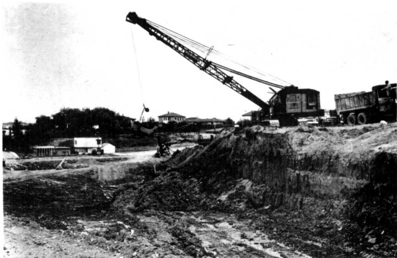
EXCAVATION GIGANTESQUE — On fait disparaître un monticule à l'ouest du Collège Bon-Pasteur actuellement en construction. Cette masse
