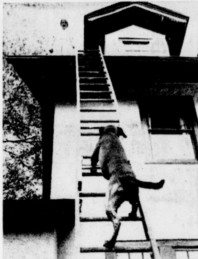
Chester, un Labrador de 6 ans, aime bien grimper dans l'échelle. A chaque jour, il accompagne au travail son maître, Dave Coogan de Mountain Lakes (N.J.), un employé de la construction. Ici, Chester s'apprête à vérifier l'installation du toit!
