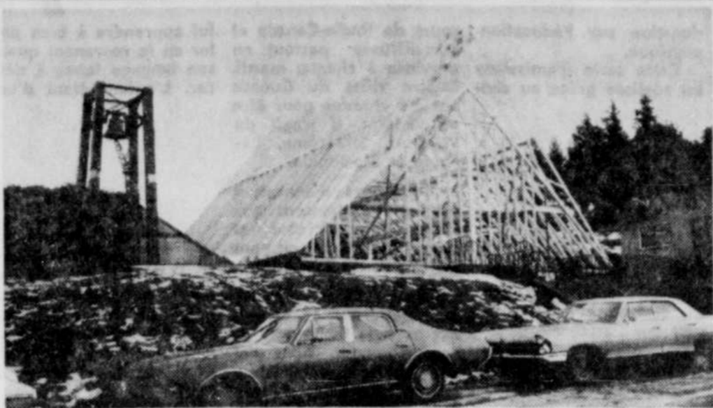
Les travaux vont bon train en vue de poser un toit sur le sous-sol de l'église Marie-Reine-du-Monde, rue Bowen sud. On se rappelle que le temple a été détruit en fond en comble par un violent incendie le 17 février 1968.
