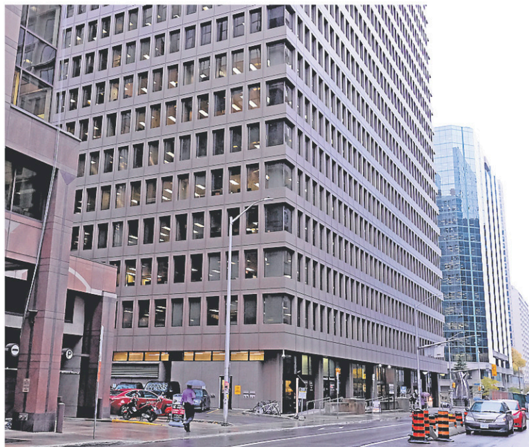
L'édifice du 300, rue Slater à Ottawa. — PATRICK WOODBURY, LE DROIT
