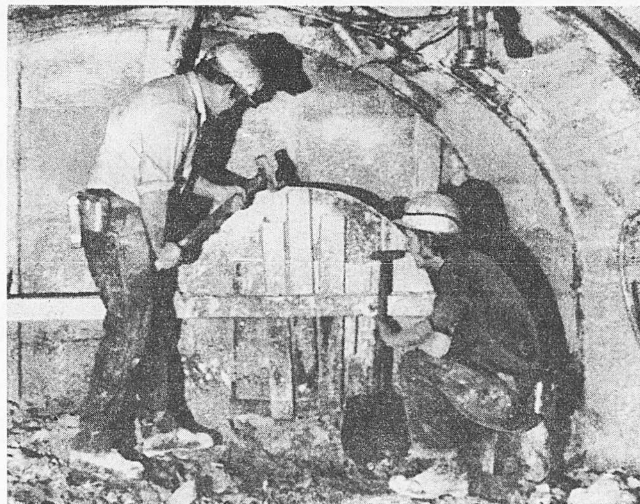
Deux mineurs bouchent une chambre d'exploitation de la mine de charbon Rawdon, près de Derby, en Grande-Bretagne. Cette mesure est rendue nécessaire afin d'empêcher les combustions spontanées susceptibles de se produire si la grève se prolongeait.
