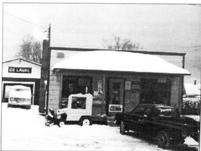
Deuxième magasin construit en 1957 près de la résidence des Turgeon.
