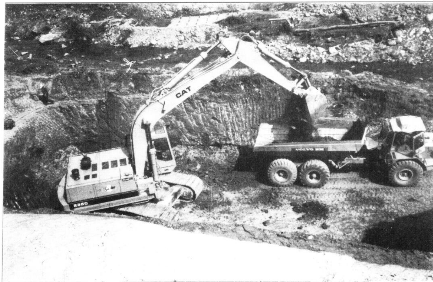
En 1991: Excavation des piliers du pont de la rivière St-Joseph sur l'autoroute 73.
